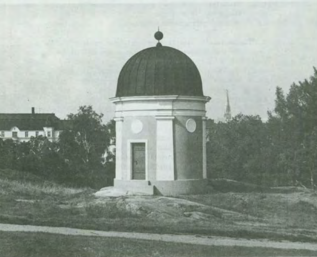
Ursan tähtitorni Helsingin Kaivopuistossa.
