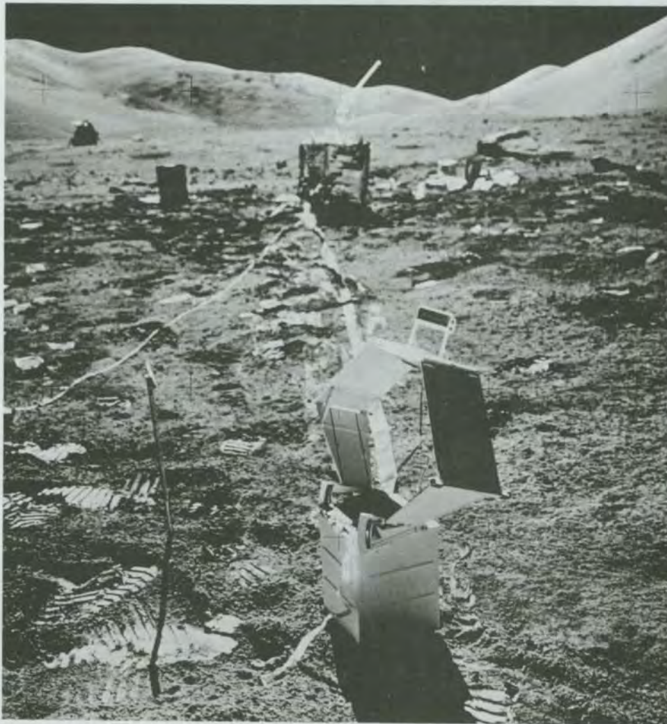
Suurimmat tähän mennessä käytetyt gravitaatioantennit ovat Maa ja Kuu. Maassa tapahtuu kuitenkin niin paljon muita häiriöitä (maanjärjestyksiä ym.), että gravitaatioosignaalien erottaminen on mahdotonta. Kuu on hiljaisempi taivaan-kappale, Siksi Apollo 17-lennolla Kuuhun vietiin Joseph Weberin suunnittelema gravimetri, joka näkyy kuvassa. Se mittasi Kuun kuoren pieniä heilahteluja noin 1 Hz taajuudella. Mittaustarkkuus oli noin 0,3 nanometriä. Gravimetri lähetti lukemiaan vuoden ajan, mutta tulosten käsittelyä ei ole vielä saatu valmiiksi. (Kuva J. Weber).
