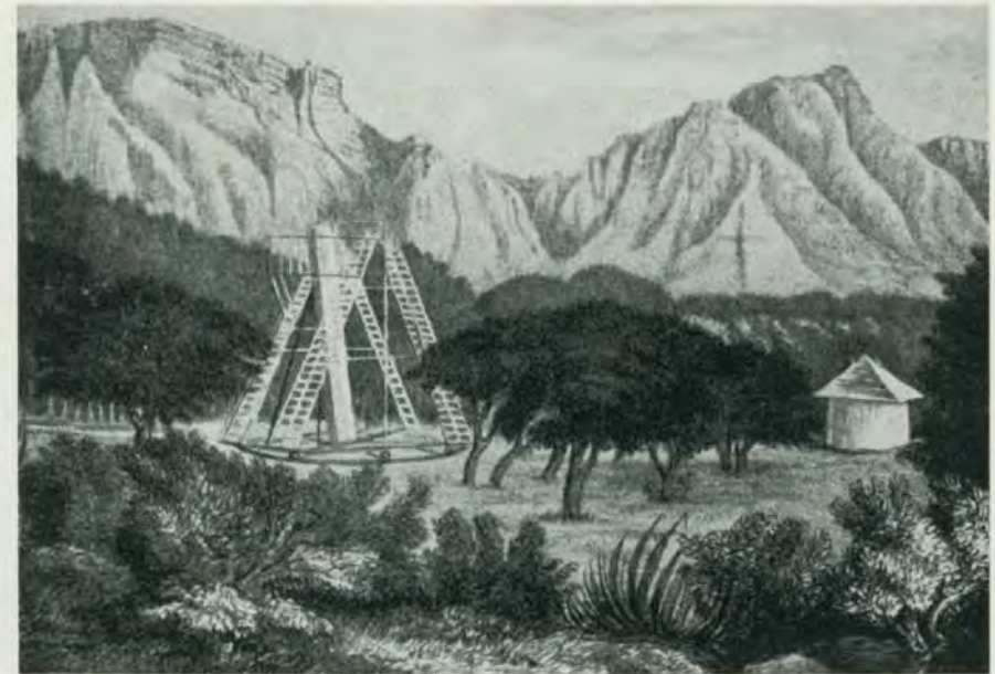
Kuva 5. John Herschelin 18 1/4 tuuman peilikaukoputki Hyväntoivonniemelle pystytettynä vuonna 1834. John Herschelin oma piirros.
